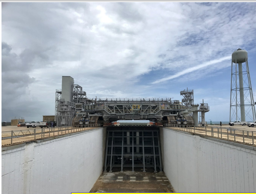
Transporteur sur chenilles CT-2 placé sur la surface de la rampe de lancement 39B pour un contrôle d'ajustement le 22 mai 2018 au Centre spatial Kennedy de la NASA en Floride
