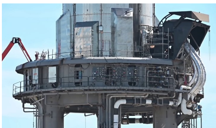
Base de lancement : alimentation de Heavy en propergols liquides.
