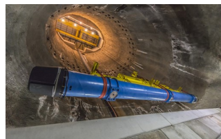
Descente d'un aimant dipôle dans le tunnel du LHC pour son remplacement.
