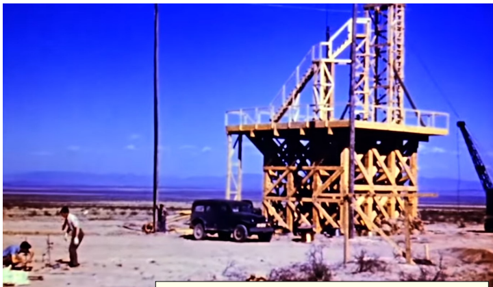
Plateforme pour le test « 100 t de TNT » en construction.
