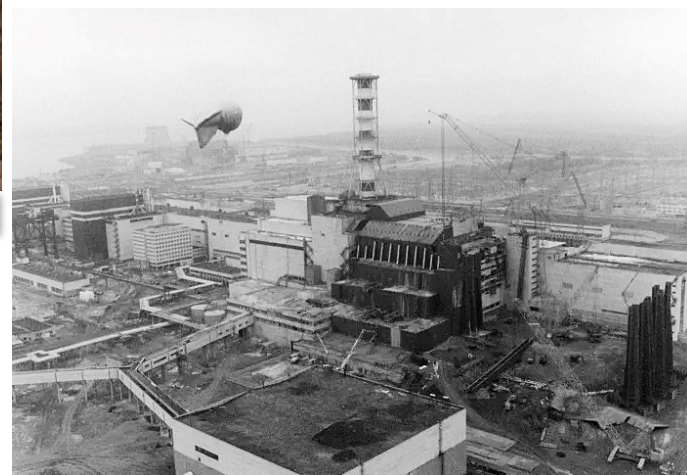
Centrale nucléaire de Tchernobyl après l'explosion du 26 avril 1986 à Tchernobyl, en Ukraine. Construction du « sarcophage ». Image : SHONE/GAMMA
