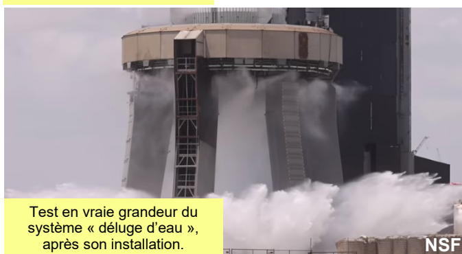
Mise en place du système « déluge d'eau », courant juillet, à la Starbase.
