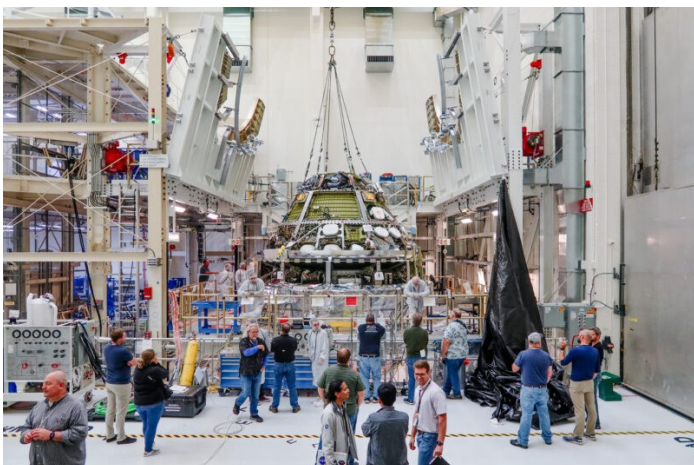
Le module d'équipage Orion d'Artemis 2 est doucement abaissé sur son module de service européen, sous le regard des techniciens du programme Orion. (Image NASA)
